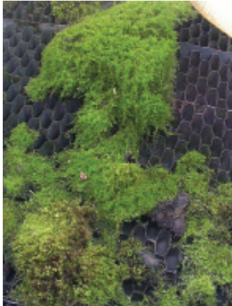
Verdunstungskühler mit Algenbewuchs - trotz Biozideinsatz
