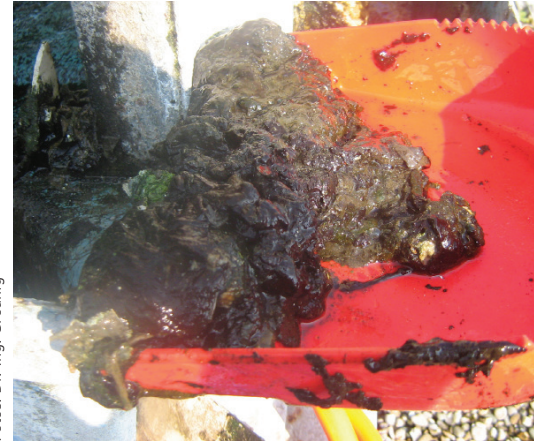
Bei hoher Schmutzfracht ist der Einsatz von Bioziden sinnlos.
